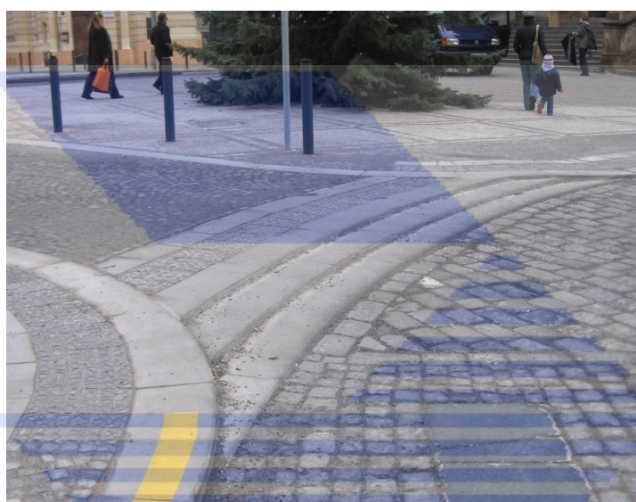
Obr. 11 Detail stupňovitého tvaru nájezdové rampy
